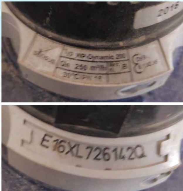
Figura 3. Dipòsit Molí Cucurull. Sala equipament hidràulic. Comptador d'entrada al dipòsit.
