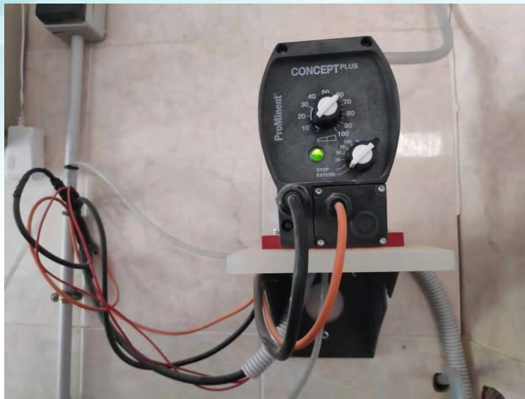
Figura 7. Dipòsit Molí Cucurull. Sala cloració. Bomba d'injecció de clor.
