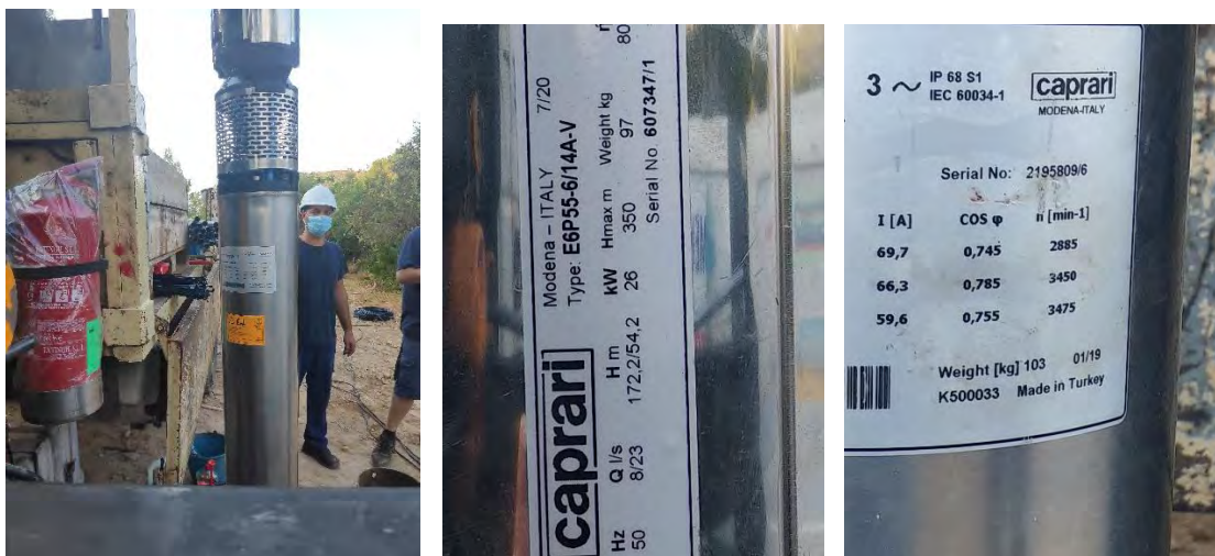
Figura 7 Instal·lació i característiques de la bomba.
