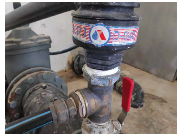
Figura 3. Dipòsit Molí Cucurull. Sala equipament hidràulic. Comptador d'entrada al dipòsit.
