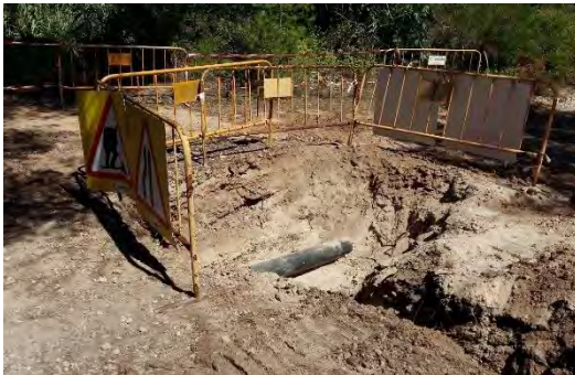
Figura 4 Punt de connexió, canonada entre el pou de Cal Llorenç i el dipòsit del Molí Cucurull pel seu pas pel costat del nou pou.
