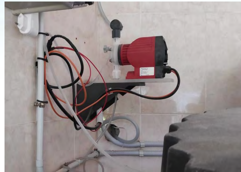
Figura 7. Dipòsit Molí Cucurull. Sala cloració. Bomba d'injecció de clor.
