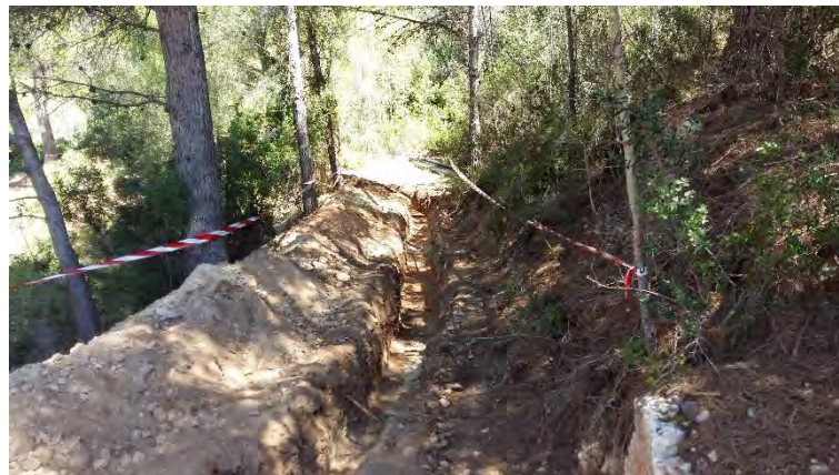
Figura 9 Rasa de la canonada de connexió.
