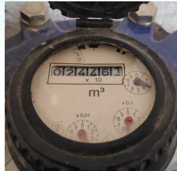
Figura 3. Dipòsit Molí Cucurull. Sala equipament hidràulic. Comptador d'entrada al dipòsit.
