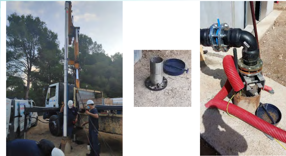
Figura 8 Muntatge de la canonada d'impulsió.
