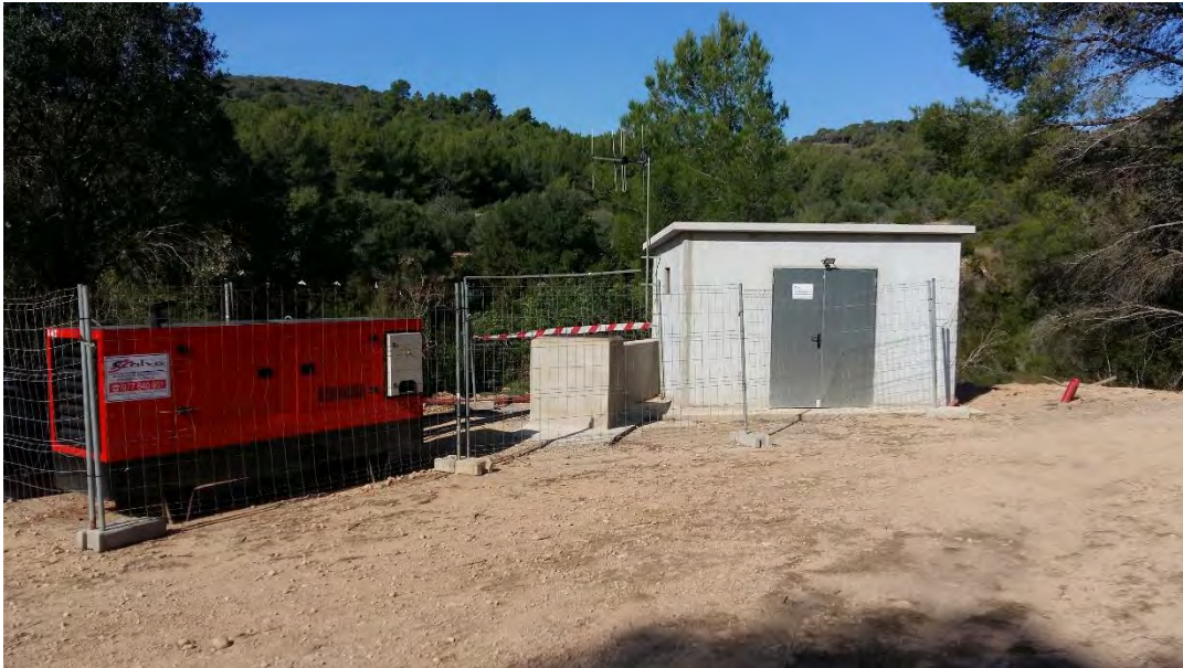
Figura 10 Vista general de la caseta.
