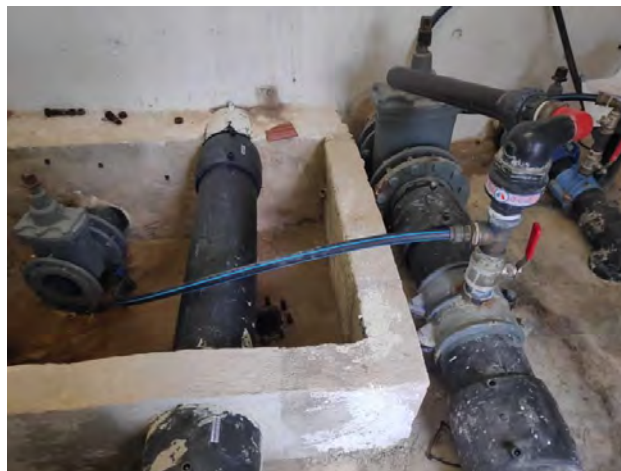
Figura 3. Dipòsit Molí Cucurull. Sala equipament hidràulic. Comptador d'entrada al dipòsit.
