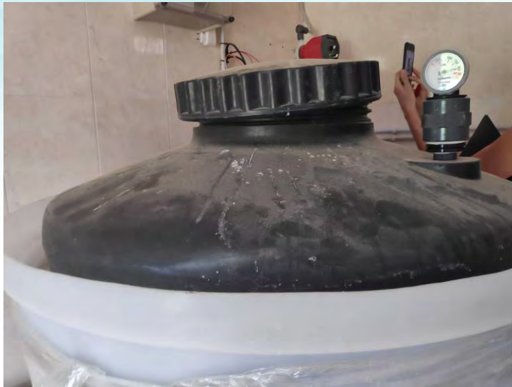
Figura 9. Dipòsit Molí Cucurull. Sala cloració. Dipòsit de clor de 900 litres i detall de la bomba de recirculació.
