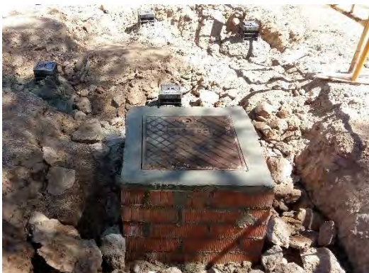
Figura 5 Punt de connexió, ventosa A.R.I. DN-40 situada dins una arqueta d'obra amb una tapa metàl·lica de 40x40cm i caputxons de les vàlvules de comporta
